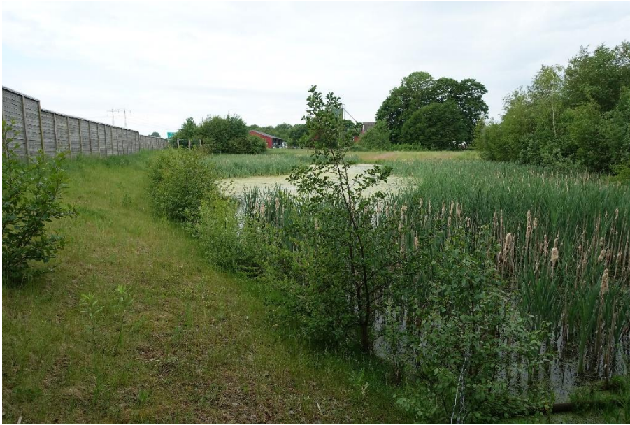
Figur 1. Bullerplank längs E22 söder om en vägdam i Skåne. Planket minskar ljus- och ljudföroreningar men till viss del även risken för att amfibier ska ta sig ut på motorvägen.
