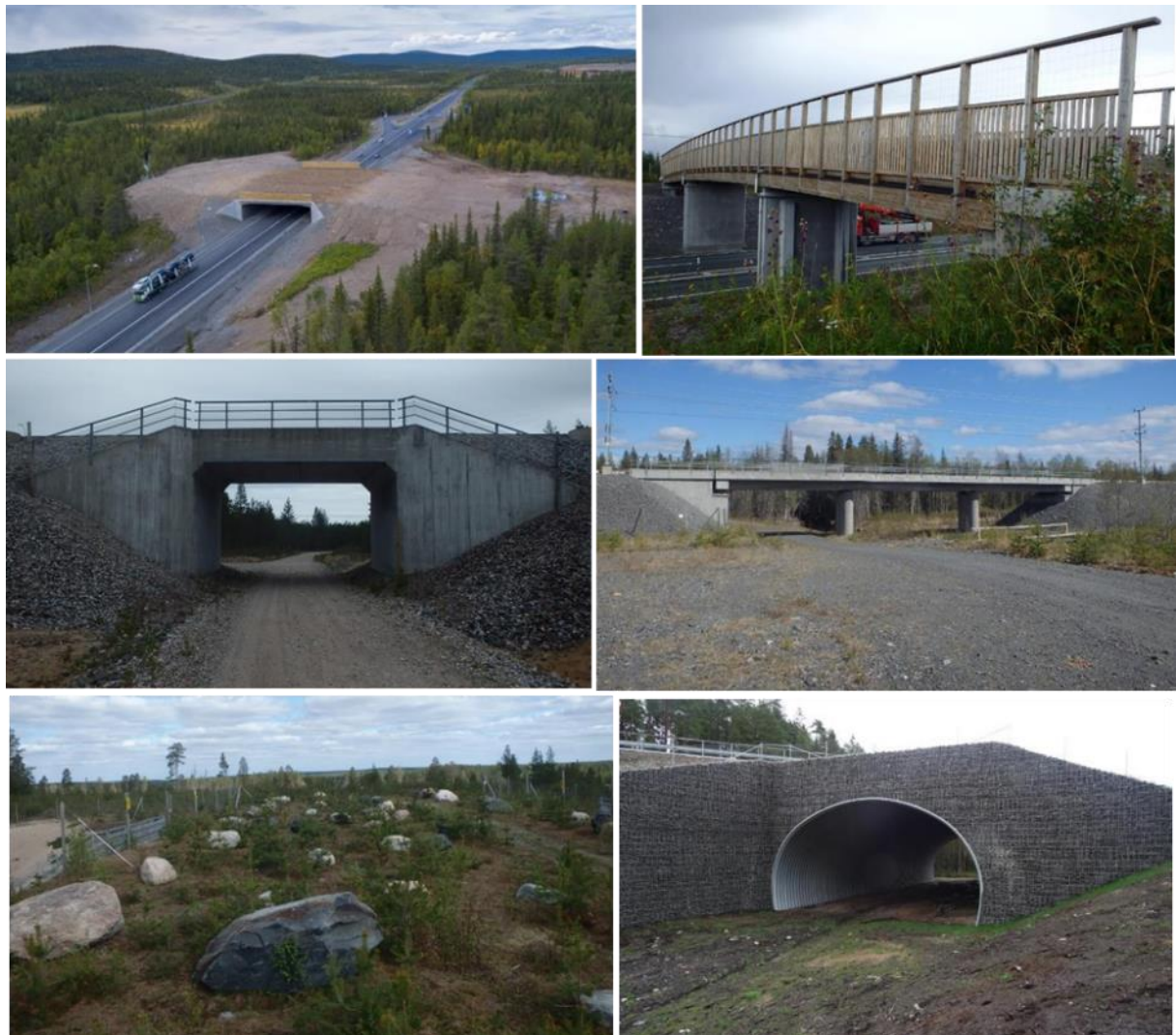
Figure 2: Bridges studied; from top left: Mertainen, Harrioja, Kåtaträskvägen, Sattaojavägen, Sangijärvi, Borås. Photos: Trafikverket.
