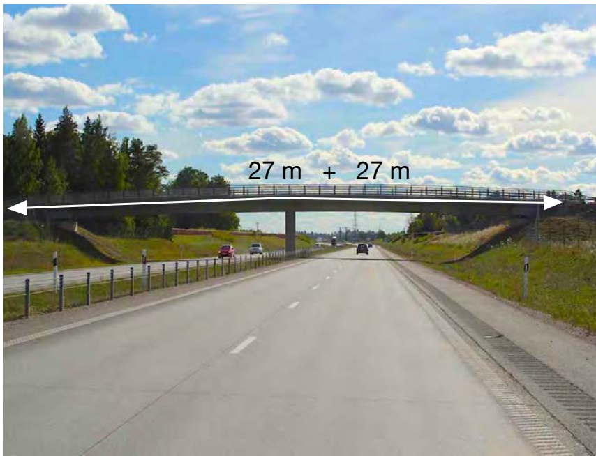
Figur 20. BaTMan Objekt 3-727-1: "Vägport för E4 under GC-väg vid Hämringe" inkluderas i den följande effektbedömningen. Bron är tillräcklig bred och relativt låg trafikerad, men samtidigt mycket lång och dessutom helt oskyddad mot trafikljus och buller från underliggande E4. Den erbjuder dock ingen effektiv passage, effektiviteten för klövvilt beräknas till enbart 12 %. Foto: ur BaTMan.
