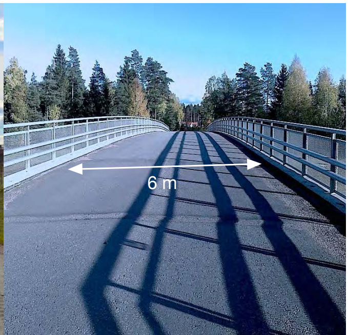
Figur 20. BaTMan Objekt 3-727-1: "Vägport för E4 under GC-väg vid Hämringe" inkluderas i den följande effektbedömningen. Bron är tillräcklig bred och relativt låg trafikerad, men samtidigt mycket lång och dessutom helt oskyddad mot trafikljus och buller från underliggande E4. Den erbjuder dock ingen effektiv passage, effektiviteten för klövvilt beräknas till enbart 12 %. Foto: ur BaTMan.
