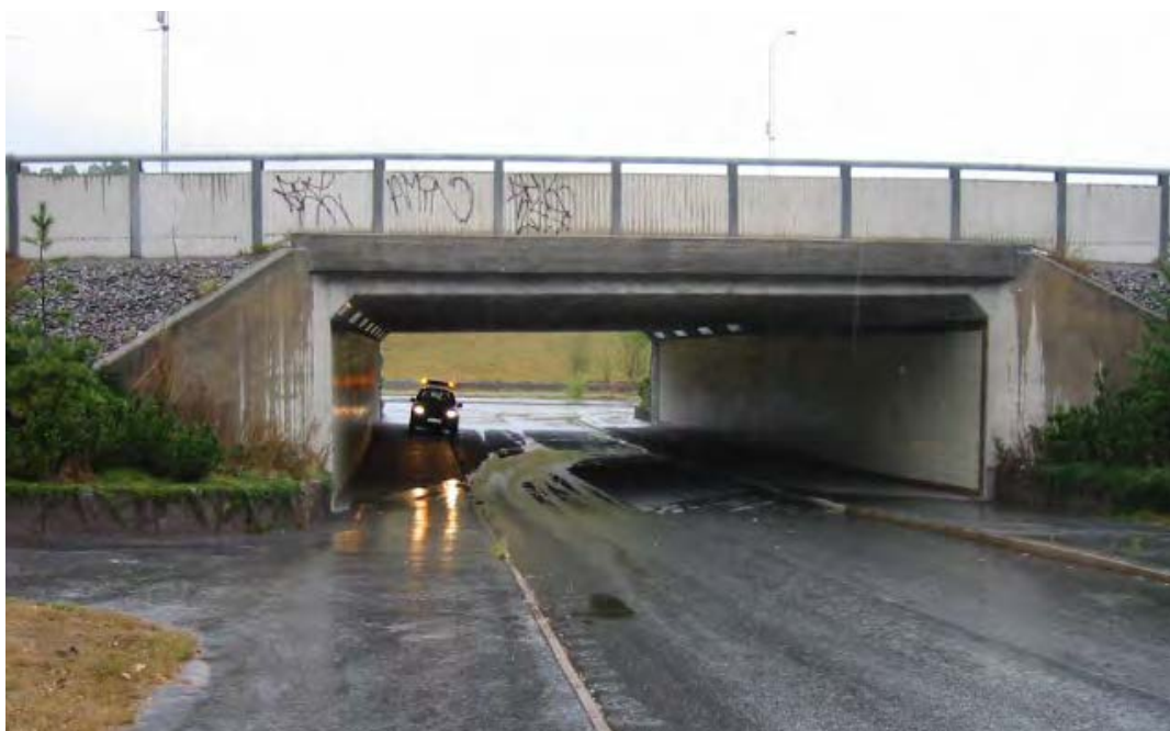
Figur 28. Bro 2-774-1: Bro under E4 över allmän väg. Bron är stor och rymlig och dessutom försedd med sikt/stänkskydd, men passagen är upplyst och med stor sannolikhet för mycket trafikerad av både människor och fordon för att kunna fungera effektivt som viltpassage. Foto: ur BaTMan.
