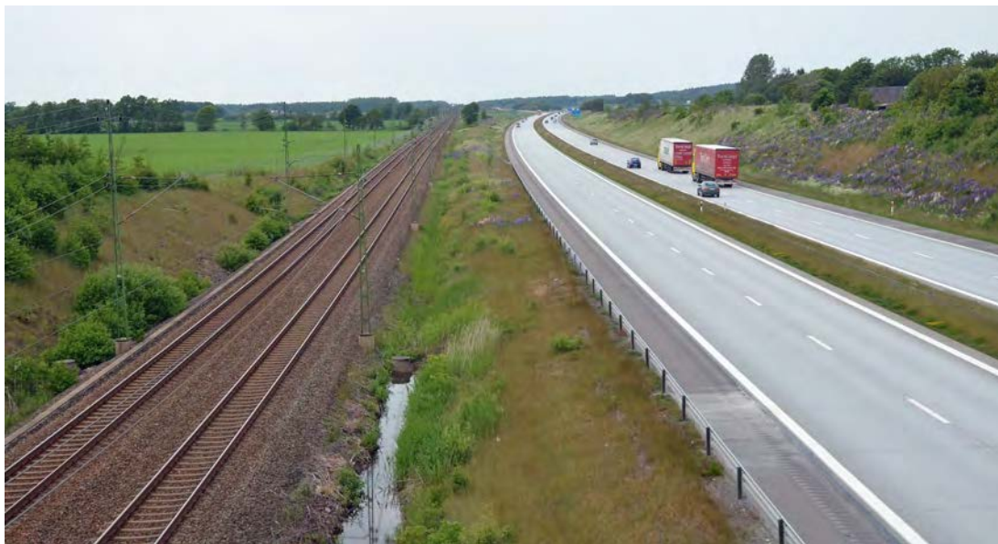
Figur 11. Väg och järnväg ligger ibland parallellt intill varandra och kan då en effektiv barriär för djur – även om trafiklederna för sig inte utgör ett hinder. E6 och Väst kustbanan.
