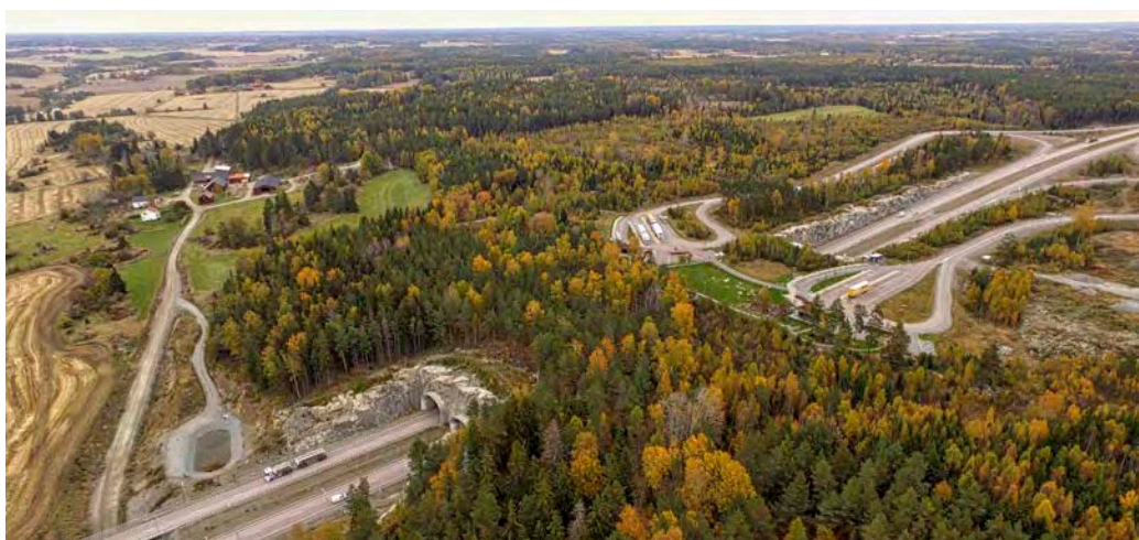
Figur 15. BaTMan Objekt 3-815: "Tunnel för E18 vid Tillinge-Ullbro". Tunneltaket har en bredd på ca 165 m och borde därmed ge tillräckligt med utrymme för djuren att passera. Foto: Andreas Seiler.
