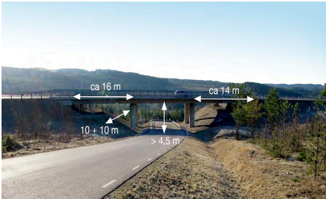
Figur 19. BaTMan Objekt 15-1417-1: "Bro för RV40 över allmän väg vid Fagerdal". Passagen erbjuder breda slänter vid sidan om vägen och inkluderas därför i effektbedömningen. Den uppnår en fullgod effektivitet för klövvilt (100 %). Bron har dessutom byggts med tanke på att tillåta passage för vilt och sporadiska kontroller har dokumenterat djurspår. Foto: ur BaTMan
