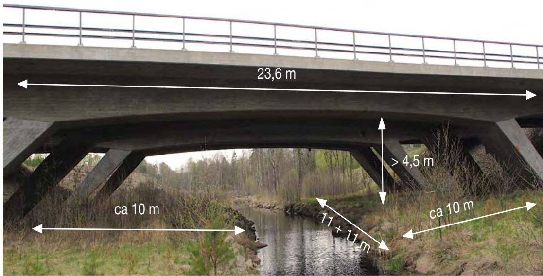
Figur 21. Objekt 11-940-1: "Bro för E4 över Lärkesholmsån vid Örkelljunga". Strandpassagerna längs ån är med ca 10 m tillräckligt breda och rymliga för att kunna fungera väl för klövvilt. Foto: ur BaTMan.
