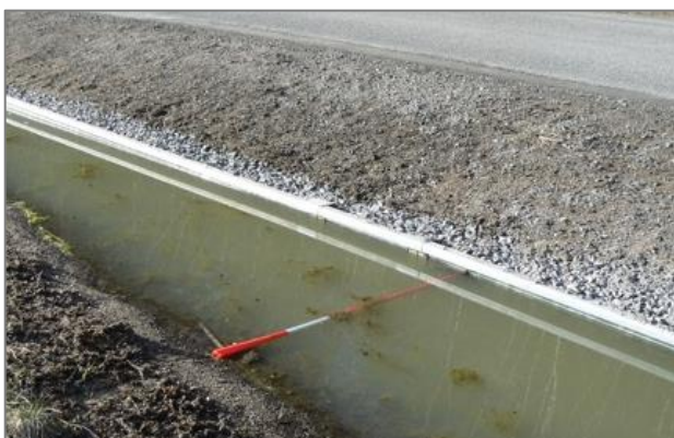
Bild 15. Södra sidan av tunnel nr 2; vägpinnen markerar tunnelöppningen. 2016-03-30.
