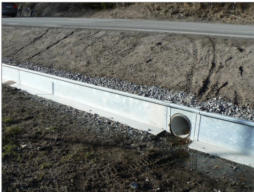
Bild 2. Ledarm samt tunnel nr 1 (plaströr), södra sidan. 2016-03-30
