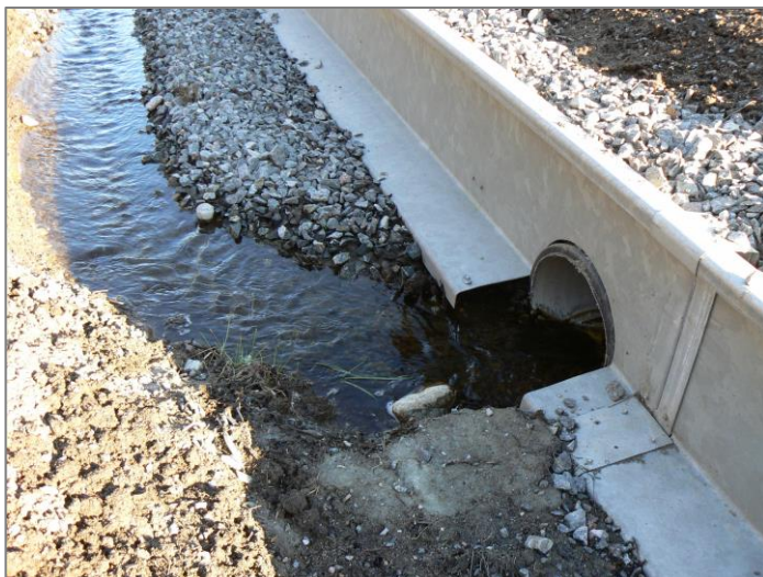
Bild 12. Tunnel nr 5, norra sidan. 2016-03-30.
