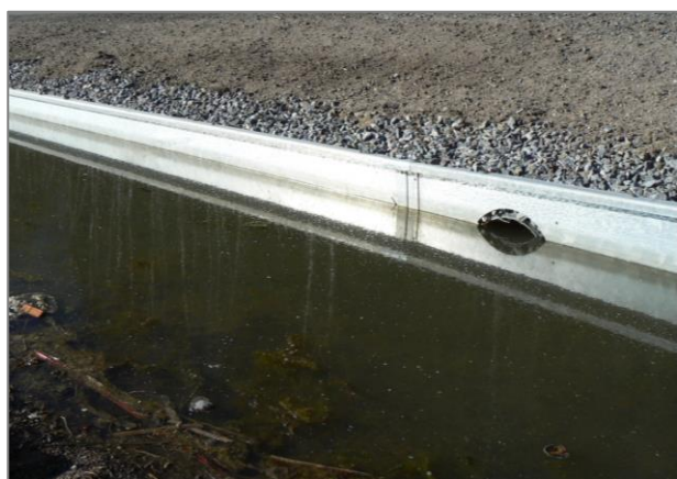
Bild 16. Södra sidan av tunnel nr 3. 2016-03-30.
