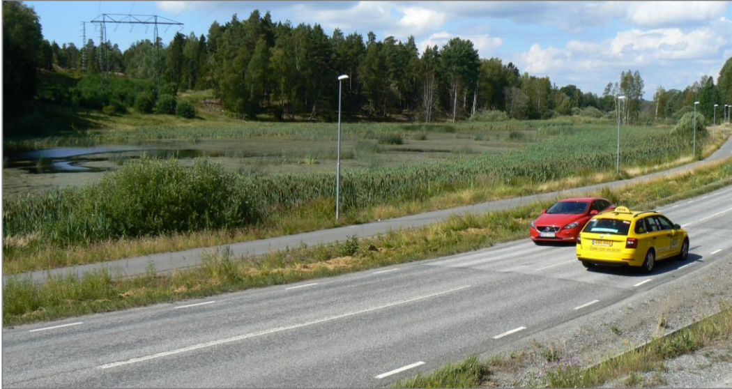
Bild 1. Skeppdalsträsk och Stavnäsvägen/väg 222. 2018-07-12
