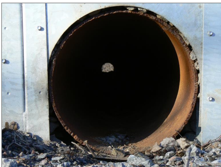
Bild 3. Tunnel nr 4 (järnrör), södra öppningen. 2016-03-30
