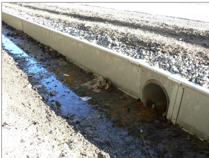
Bild 13. Tunnel nr 2, norra sidan. 2016-03-30.
